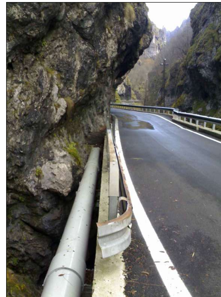
FIG.4: ATTRAVERSAMENTO AEREO CON DN 450mm
