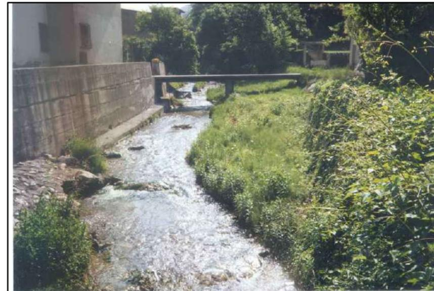
FIGURA N°5: Stato dei luoghi prima degli interventi di sistemazione idraulica. Evidente il degrado e la pura cementificazione delle protezioni di sponda realizzate negli anni settanta.
