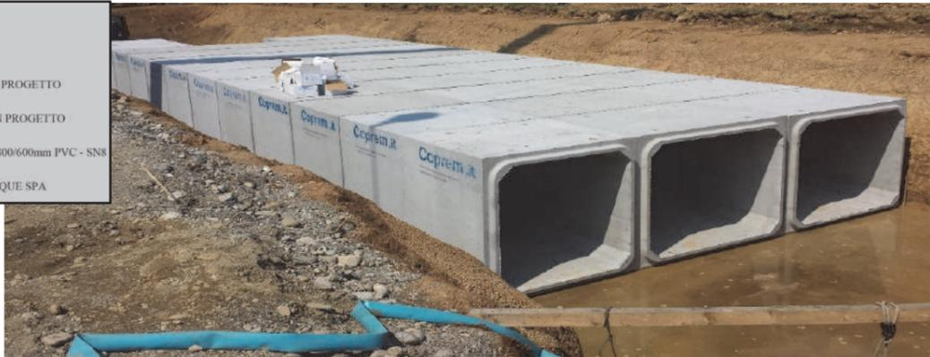
**L'invaso è stato ottenuto posando tre "canne" parallele di manufatti scatolari, della lunghezza complessiva di 50 ml, altezza interna dei manufatti 2.0m e larghezza utile 2.5m per due canne e 2.0m per la terza.**
